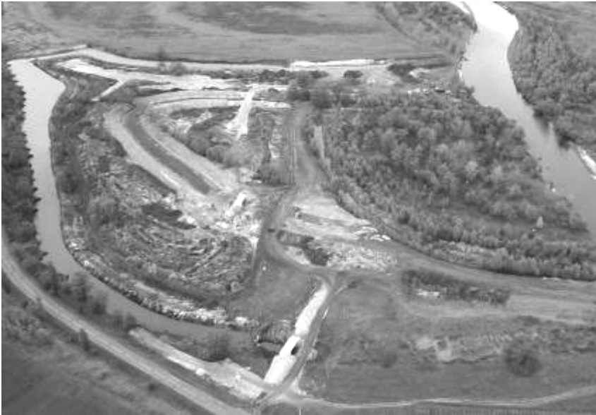
Гідронамив, будівництво каналів та котеджів у с. Соболівка на березі Десни, 2008 р.
