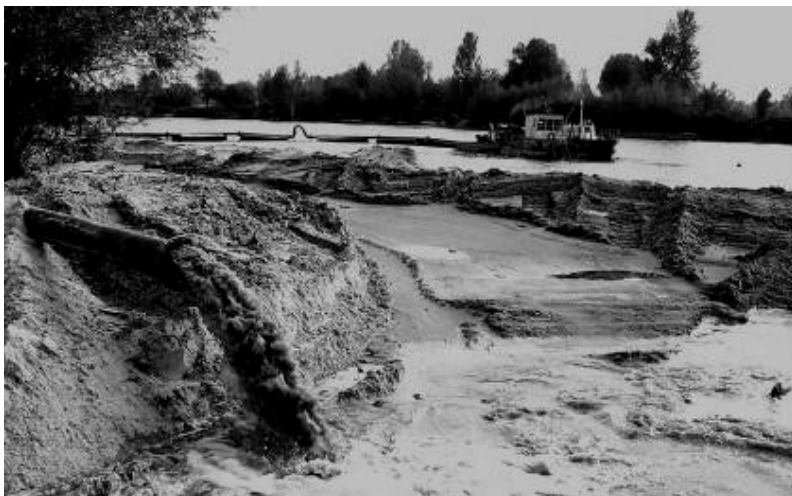
Гідронамив під будівництво на березі Десни у с. Зазим'я, 2005 р.
