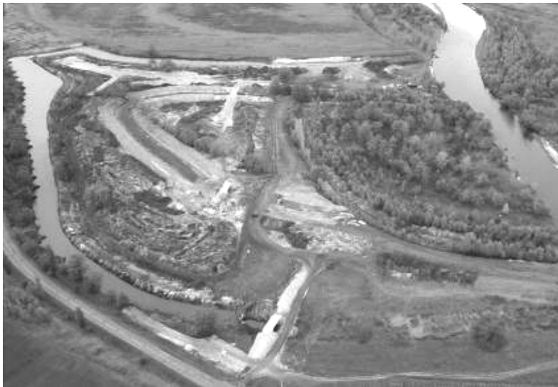
Гідронамив, будівництво каналів та котеджів у с. Соболівка на березі Десни, 2008 р.
